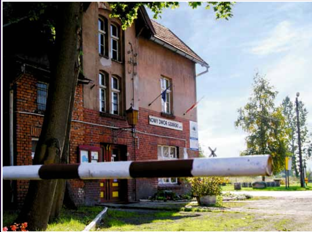
STACJA KOLEI WĄSKOTOROWEJ W NOWYM DWORZE GD.
