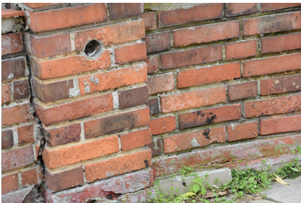
Fotografia nr 15 – Miejsce pobrania próbki nr 1 do badań laboratoryjnych na obecność soli budowlanych.
