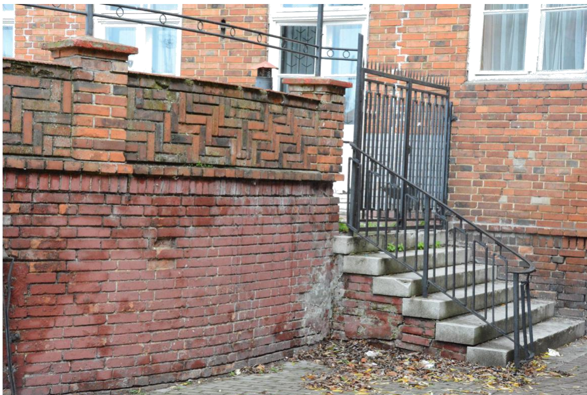
Fotografia nr 5 – Widok rotundy od strony południowo-wschodniej.
