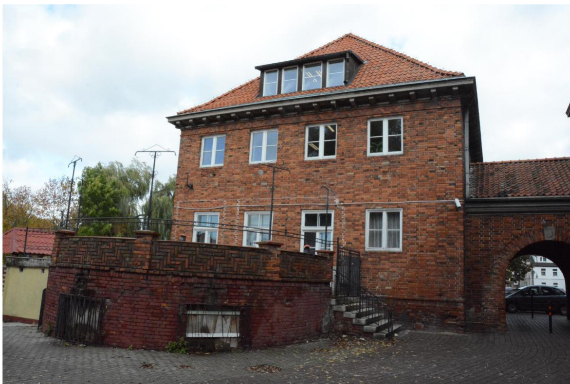
Fotografia nr 4 – Widok rotundy od strony południowo-zachodniej.
