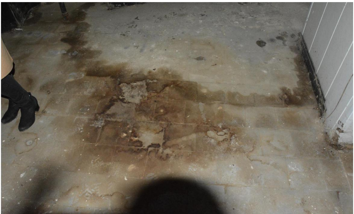
Fotografia nr 12 – Na posadzce w lokalu rotundy po zalaniu przez wodę z rzeki rozwinęły się grzyby.
