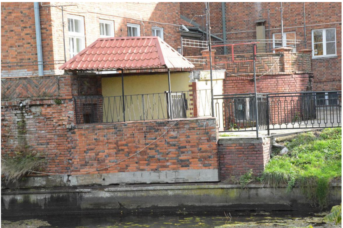
Fotografia nr 2 – Widok rotundy od strony rzeki (kierunek zachodni).
