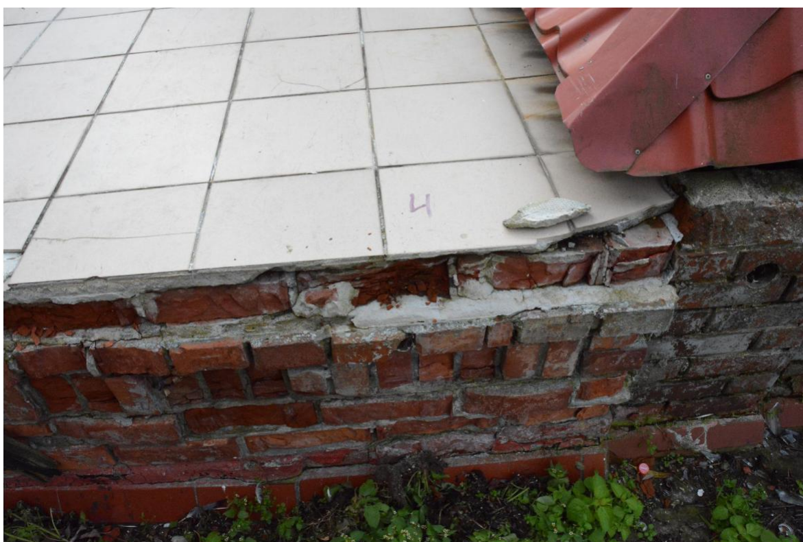
Fotografia nr 18 – Miejsce pobrania próbki nr do badań laboratoryjnych na obecność soli budowlanych.
